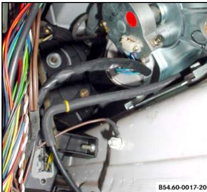
Punto de masa en el interior de la cabina
